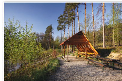
Přístřešek u rybníka Kamenec
